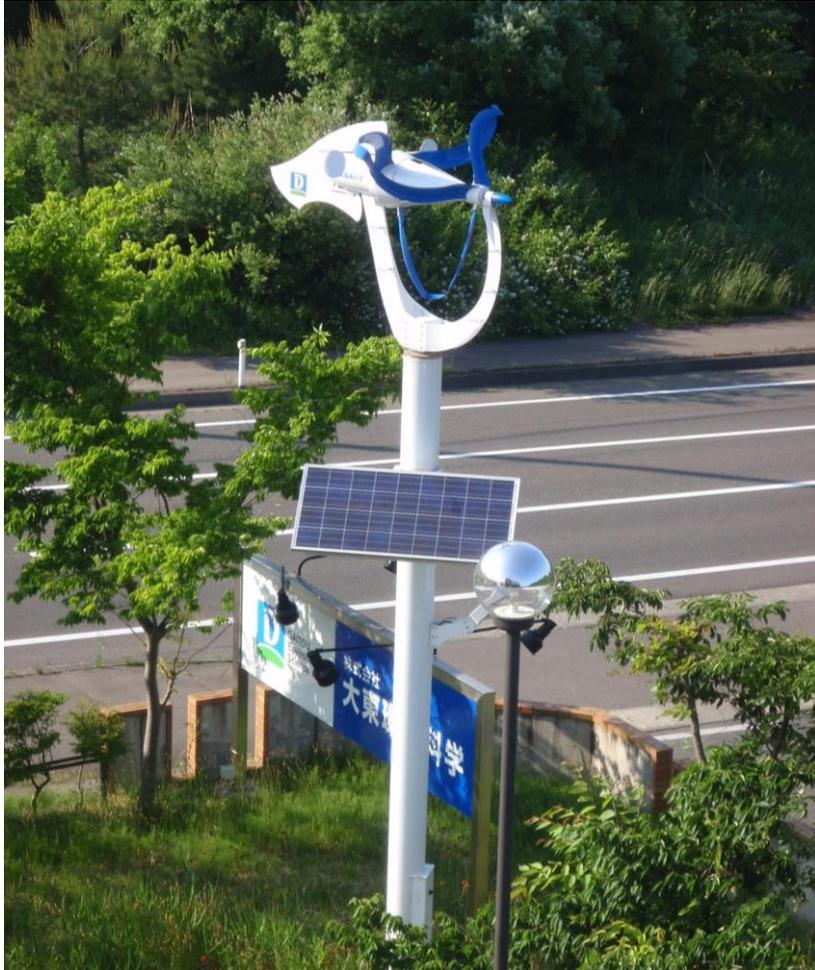
巻末写真：弊社出入口付近に設置されている小型風力発電機（夜間照明用）。
