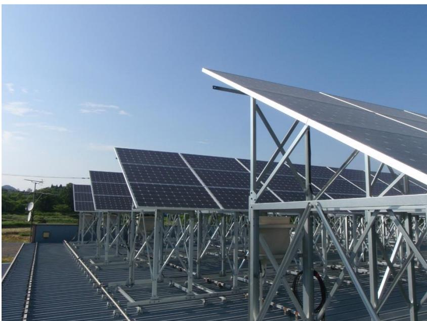
弊社屋上に設置された太陽光発電装置：パネル 4 列で最大出力は 45kW。
